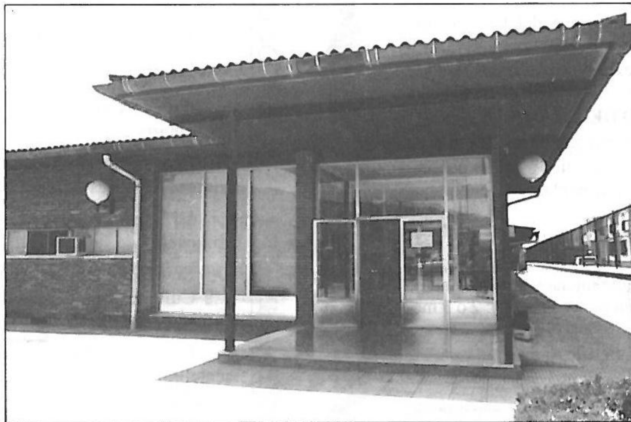
Fachada Centro de Salud
